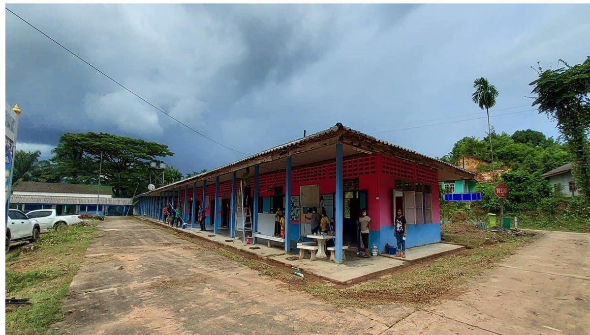
โรงเรียนบ้านโชคอำนวย กระบุรี
