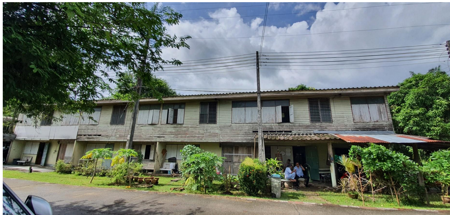
สถานที่ก่อสร้าง
